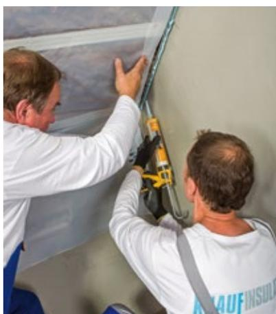
8. Parozábrana Homeseal LDS 100 se k přiléhajícím stavebním konstrukcím dotěsňuje pomocí těsnícího tmelu Homeseal LDS Solimur nebo Homeseal LDS těsnícího pásku, vzájemné spoje pomocí pásky Homeseal LDS Solifit nebo Homeseal LDS Soliplan.
