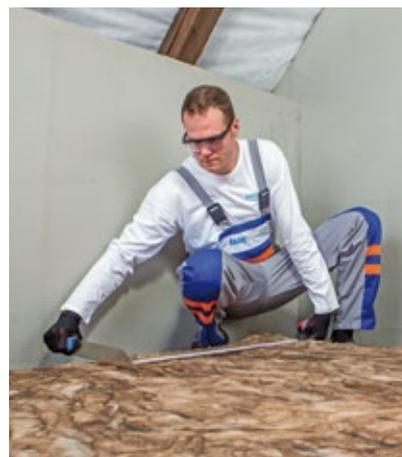
3. Jednotlivé pásy izolace se řežou o jeden až dva centimetry širší než je naměřená mezera mezi krokvy. Řez vedeme kolmo k rovině izolace.
