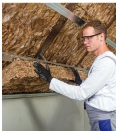
7. Vrstva izolace pod krokvy se vkládá do nosného roštu sádkartonového podhledu.
