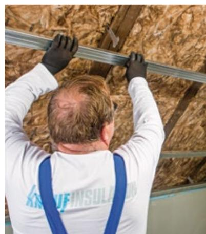
6. Montáž nosné konstrukce podhledu s použitím krokrových závěsů.
