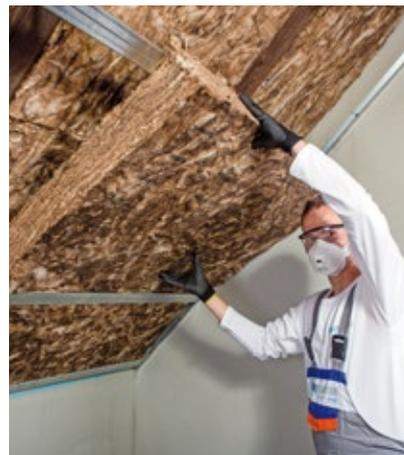
3. Vložení první vrstvy izolace do pomocného roštu (na obrázku Unifit 120 mm).
