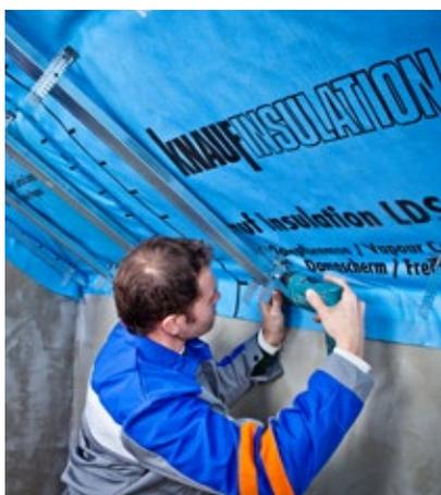
7. Nosný rošt sádkartonového podhledu je namontován kolmo na pomocný rošt pomocí přímých závěsů. Přímé závěsy je vhodné podložit PE pěnovou těsnící páskou nebo LDS těsnící páskou.
