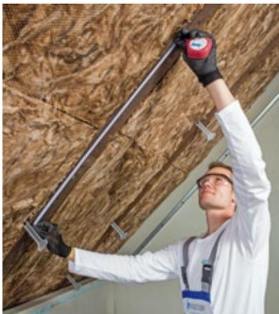
1. Před vložením izolace mezi krokve se namontují krokrové závěsy pro zavěšení pomocného roštu. Postup pro zateplení mezi krokvy je stejný jako na str. 5.
