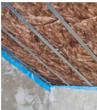
8. Poslední vrstva izolace v nosném roštu pod parozábranou. V této vrstvě je vhodné provést instalaci například elektrických kabelů – bez porušení vzduchotěsné vrstvy.
