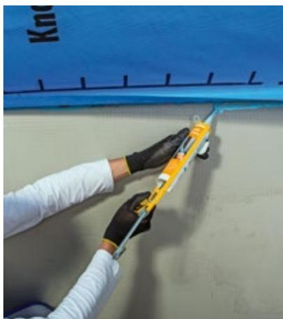
5. Při montáži vzduchotěsné parozbrzdy se po celém obvodu připraví Homeseal LDS těsnící pásek nebo nanese tmel na parozábrany Homeseal LDS Solimur.
