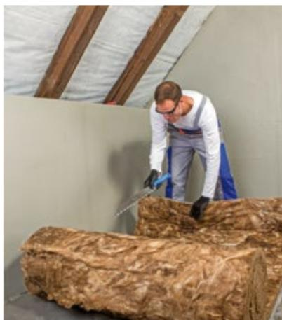
2. Je-li použita kontaktní podstřešní fólie (například Homeseal LDS 0,04) zvolíme izolaci o stejné tloušťce jako je výška krokví.
