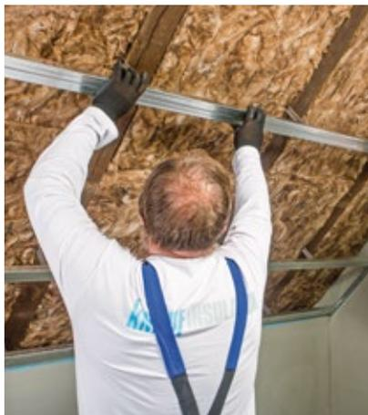
2. Pomocný rošt vymezuje prostor pro vložení první vrstvy izolace pod krokvy. Osová rozteč profilů pomocného roštu je 800 mm.
