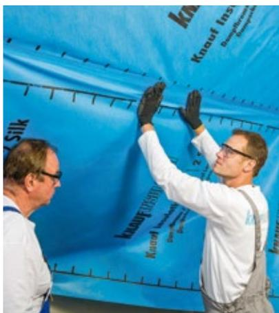
4. Parozbrzda Homeseal LDS 2 Silk vytváří vzduchotěsnou a difúzně částečně otevřenou vrstvu. Klade se po jednotlivých pásích.
