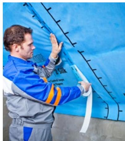
6. Vzájemné spoje fólií se vzduchotěsně spojí s pomocí pásky Homeseal LDS Solifit nebo Homeseal LDS Soliplan.
