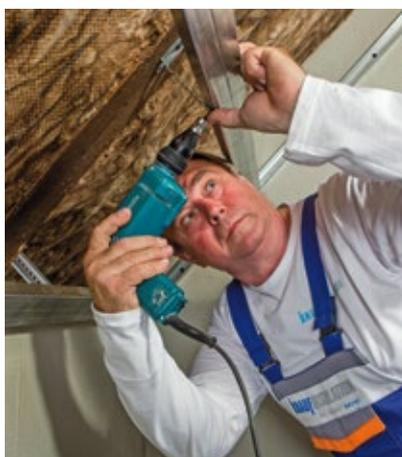
5. Montáž nosné konstrukce podhledu s použitím přírodních závěsů.
