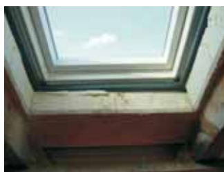
Obr.22 - pracovní otvor pro střešní okno
