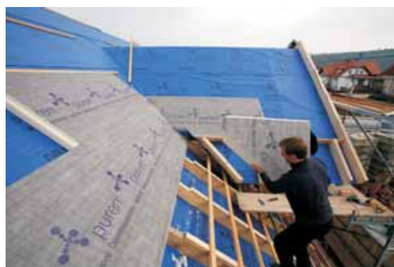
Obr.41 - montáž úžlabí
