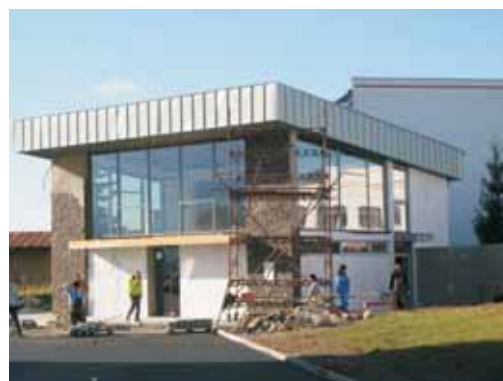
Obr.42 - montáž plechové střechy - titanžinek
