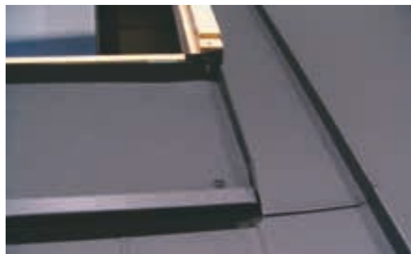
Klempřířské spojení čelního oplechování a boční šablony.
