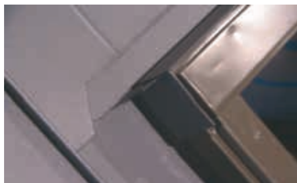
Osazení zadní části oplechování z hladkého plechu a uchycení třetí šablony zaháknutím o toto oplechování.
