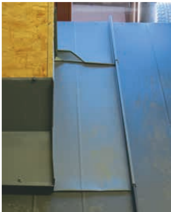
Obr. i, j – Osazení a zaháknutí třetí šablony o zadní oplechování.
