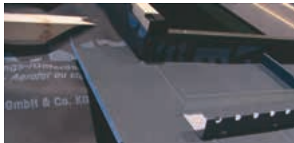
Osazení spodních šablon upravených do potřebného tvaru.
