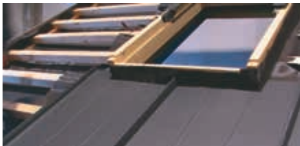
Osazení spodních šablon upravených do potřebného tvaru.
