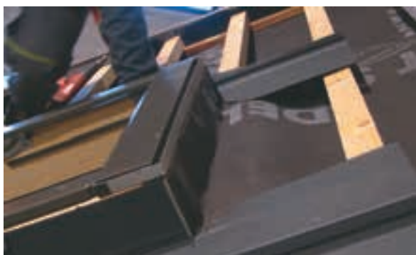
Osazení zadní části oplechování z hladkého plechu a uchycení třetí šablony zaháknutím o toto oplechování.
