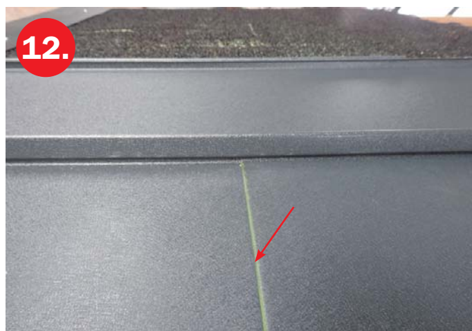
Lehkým poklepem paličkou je vhodné krytinu ve spoji stlačit.
