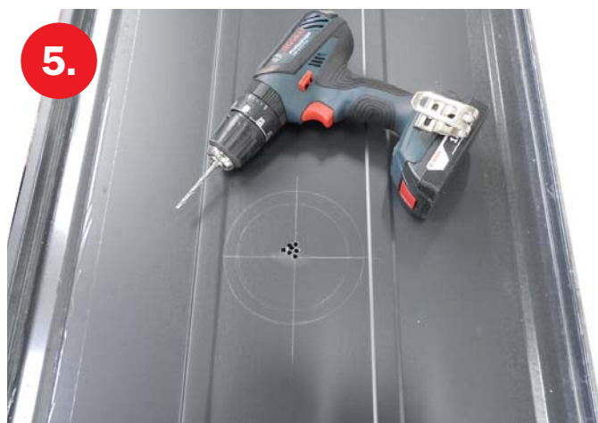
5. Ve středu odvrtáme, nebo prorazíme otvor
