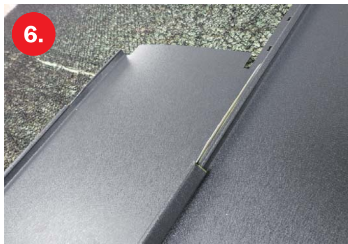
Spodní díl krytiny napojovaného pásu se nacvakne do zámku.
