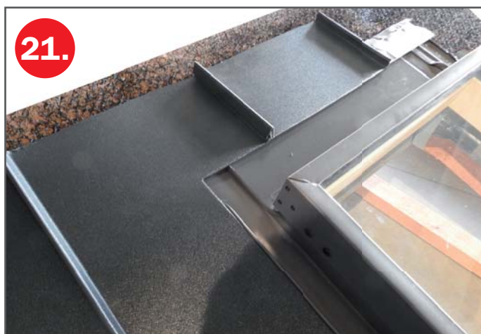
Osazení dílů krytiny nad oknem, na které se naváže boční díl krytiny na opačné straně výlezu.
