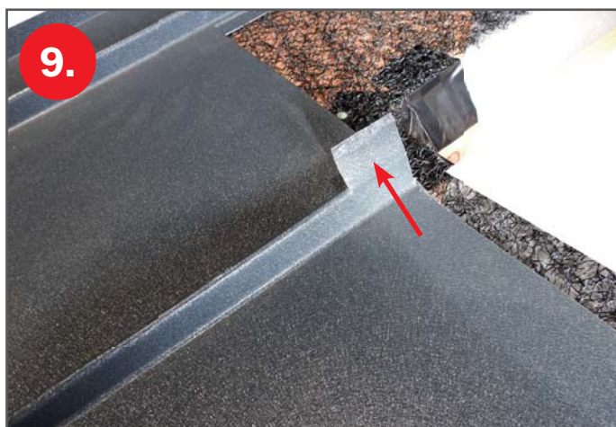
9. Příprava krytí na horním dílu zámku krytiny
