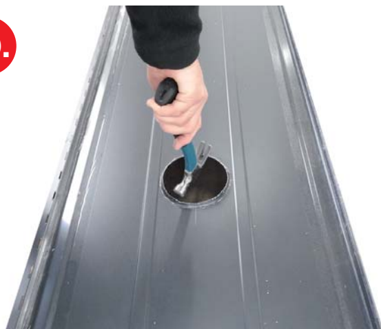
Finální dotvarování provedeme kladívkem
