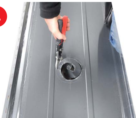
Vystřihujeme po spirále. Je nutná pečlivost, aby nevznikaly otřepy
