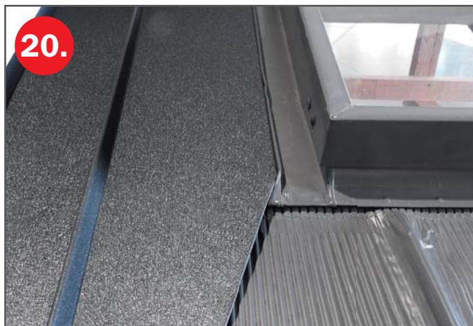
Nutná je přesnost a preciznost. Vzdálenost hrany bočního dílu krytiny od stojaté drážky lemování je cca 2-3 mm.
