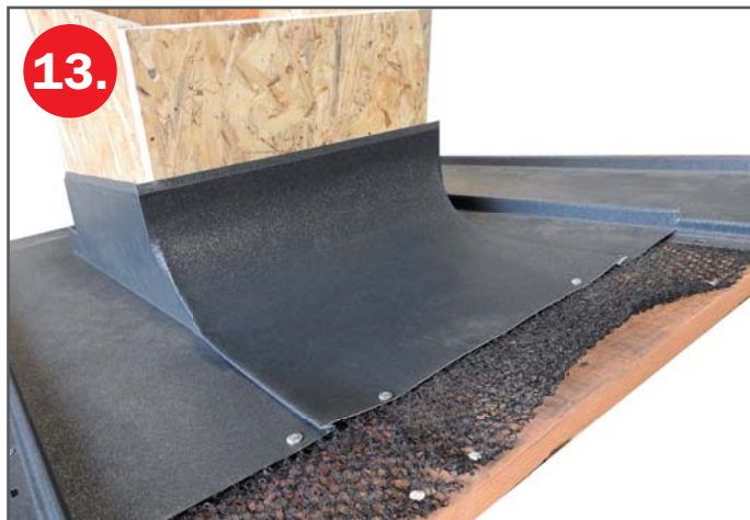
Sesazení zadního dílu lemování s díly bočními.
