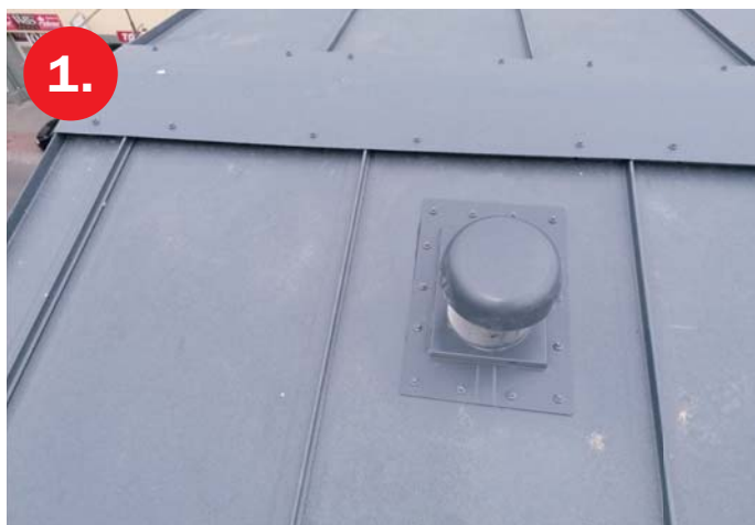
1. Prostupový plastový, nebo pryžový prvek sám o sobě nezajišťuje vodotěsnost
