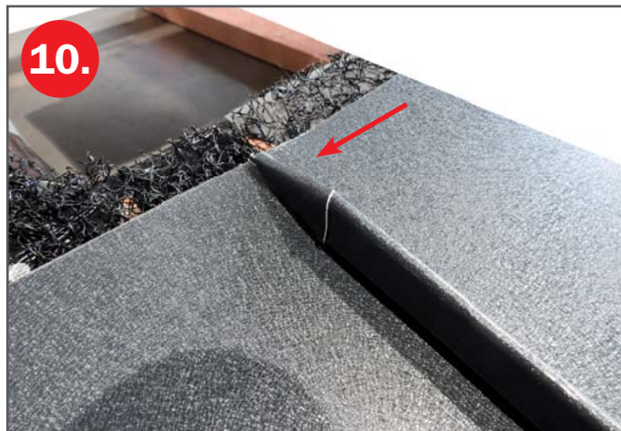
10. Krytí na horním dílu zámku krytiny
