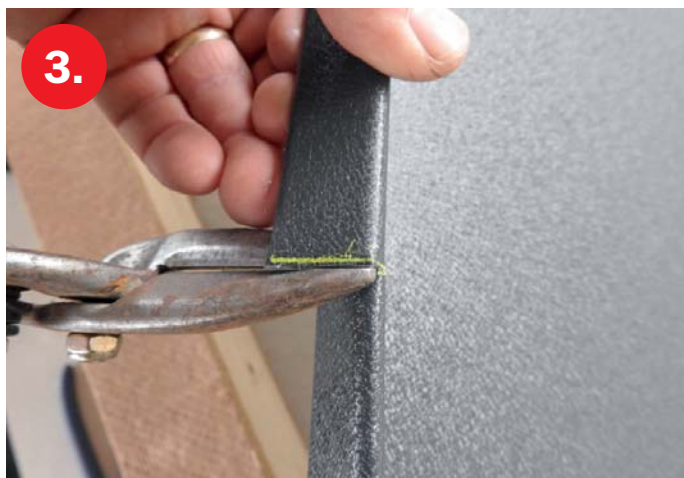
Na spodním dílu krytiny je nutné vystřihnout zámky
